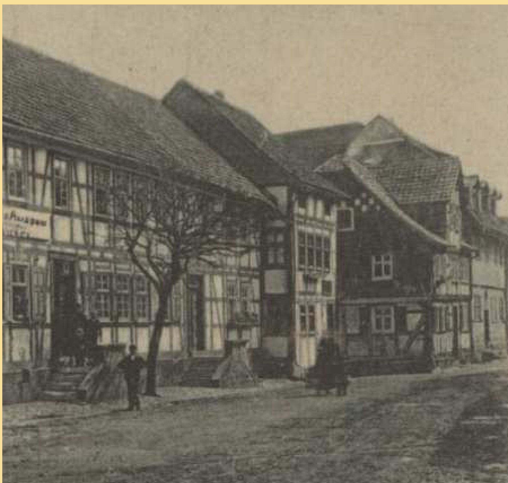
Jüdische Wohnhäuser in der Bilsteinstraße
